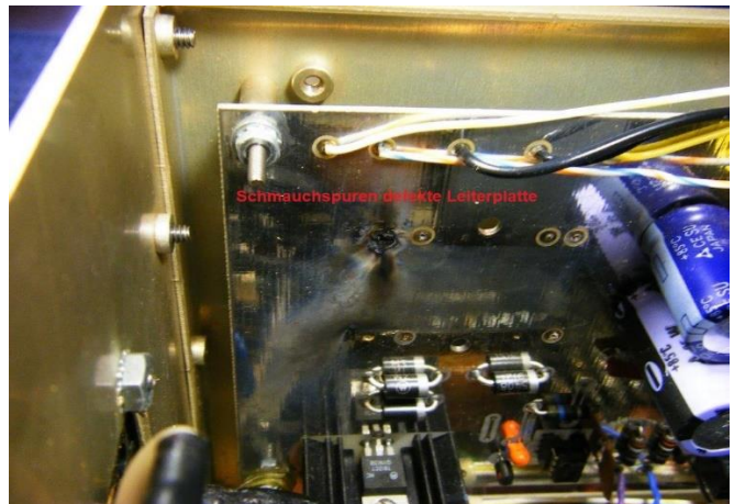
Leiterplattenschaden durch zu geringe Abstände
